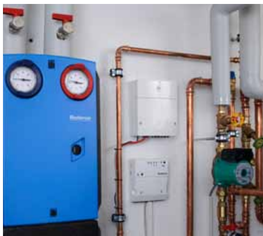
Das Gateway macht jeden von der Logamatic EMS geregelten Buderus Wärmeerzeuger internetfähig.
