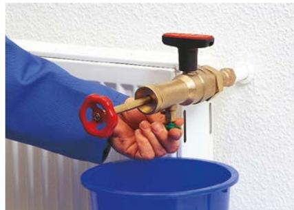
**5.** Entleerungshahn öffnen, auslaufendes Wasser auffangen und Entleerungshahn wieder schließen.
