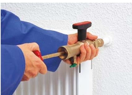
**3.** Die Spindel am Handrad langsam bis zum Anschlag zurückziehen.
