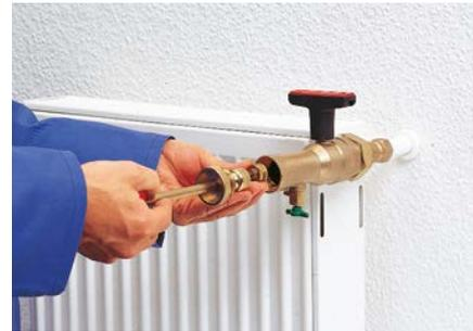
**7.** Demontiertes Thermostat-Ventiloberteil aus der Aufnahme der Spindel herausnehmen.
