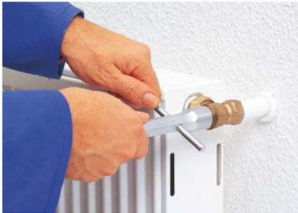
**1.** Zur Montage zunächst Thermostat-Ventiloberteil mit einem 19 mm-Sechskantschlüssel (Art.-Nr. 2001-00.258) leicht lockern.
