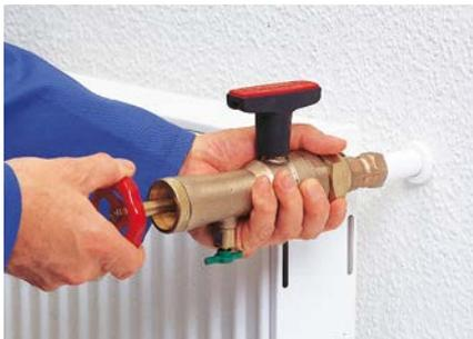
**2.** Montagegerät auf Thermostat-Ventilunterteil aufschrauben und Spindel eindrücken, bis spürbare Einrastung erfolgt. Handrad nach links drehen, bis das Thermostat-Ventiloberteil aus dem Gehäuse gelöst ist.
