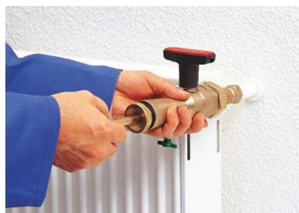
**6.** Verschlussstück öffnen und Spindel nach hinten herausnehmen. Wasser auffangen.
