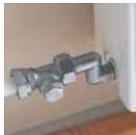
**Passgenau: Kermi Adapter-KD für Kompakt-Flachheizkörper.**
