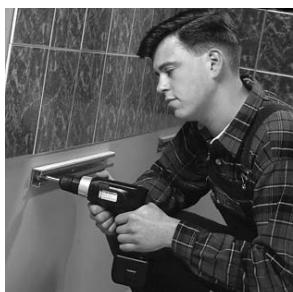
1. Wannenleisten mit beiliegenden Schrauben 6x60 und Dübeln MZ8 an der Wand befestigen. Abstand von OK Wannenleiste bis UK Fliese = Stärke des Wannenrandes + 5mm (für Silikonfuge). Abstand Wannenleisten von Außenkante Wanne ca. 5cm.
