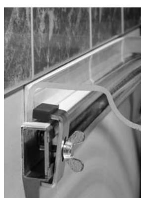
3. Nach dem Aufstellen der Wanne den Wannenrand mittels der Klemmbügel und Flügelschrauben befestigen.
