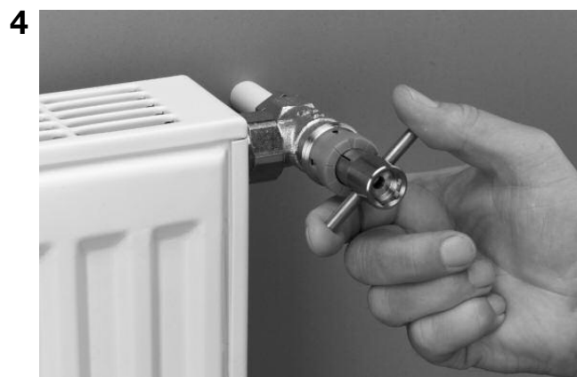
Tourner la vis de préréglage à la droite jusqu'à la butée à l'aide de la clef.
