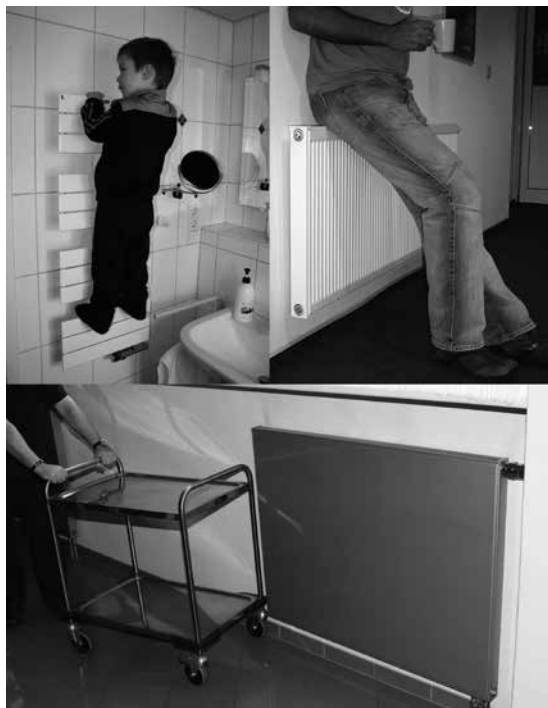
Abb. 108 Sach- und Personenschäden zu vermeiden, ist eines der Ziele der VDI 6036. Deshalb ist der sogenannte „vorhersehbare Fehlgebrauch“ ein grundlegender Bestandteil dieser Richtlinie.
