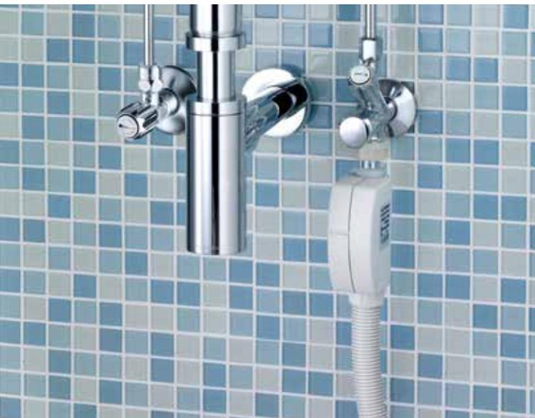
Filter Kombi-Eckventil (Anschluss-Schlauch mit Magnetventil)
