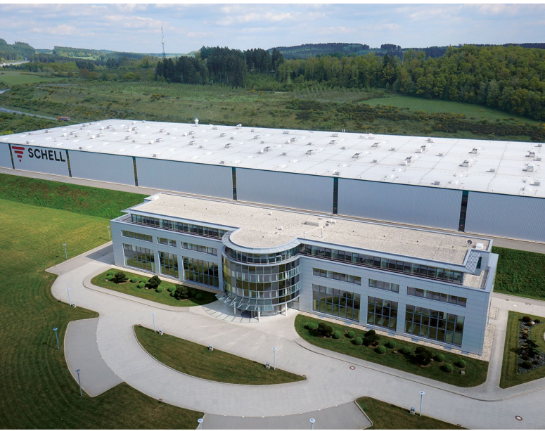
Werk 1 Produktion mit Verwaltungsgebäude und Schulungszentrum
