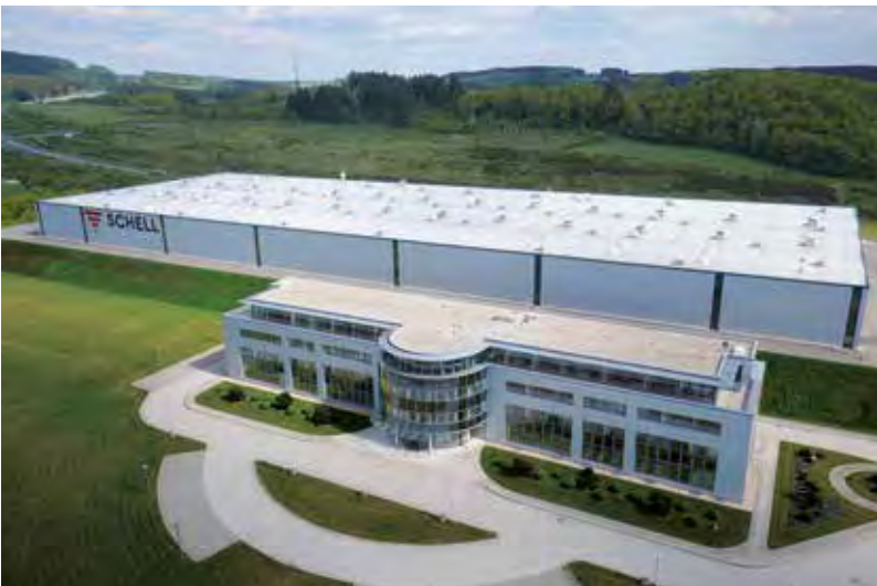
Werk 1 Produktion mit Verwaltungsgebäude und Schulungszentrum
