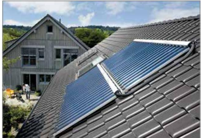
Abb 6: Nutzung von Solarenergie durch Röhrenkollektoren
