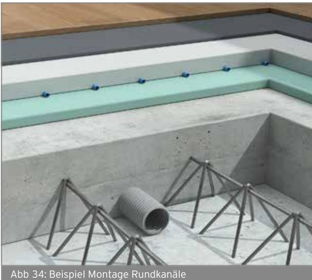
Abb 34: Beispiel Montage Rundkanäle
