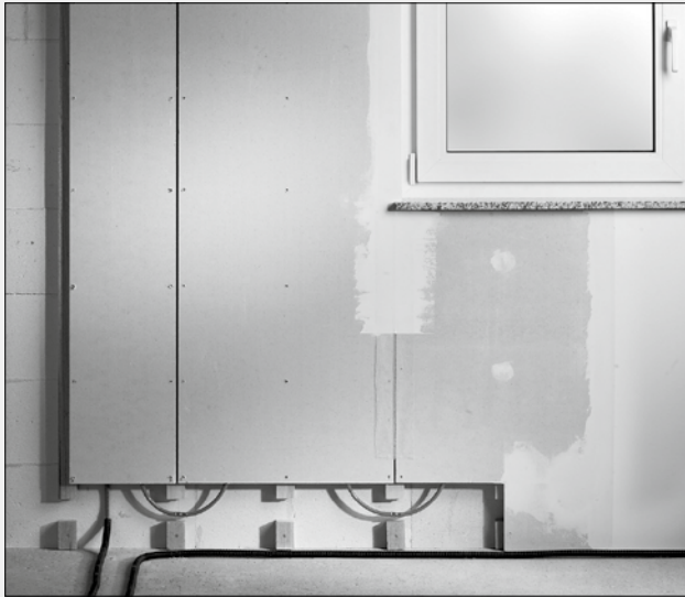
Das Trocken-Wandheizungssystem mit integrierten Polybuten-Rohren.
