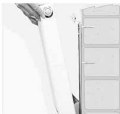
Heizkörper unten einhängen.
