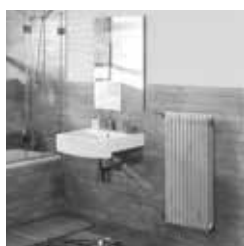
VORHER: Alter Heizkörper
