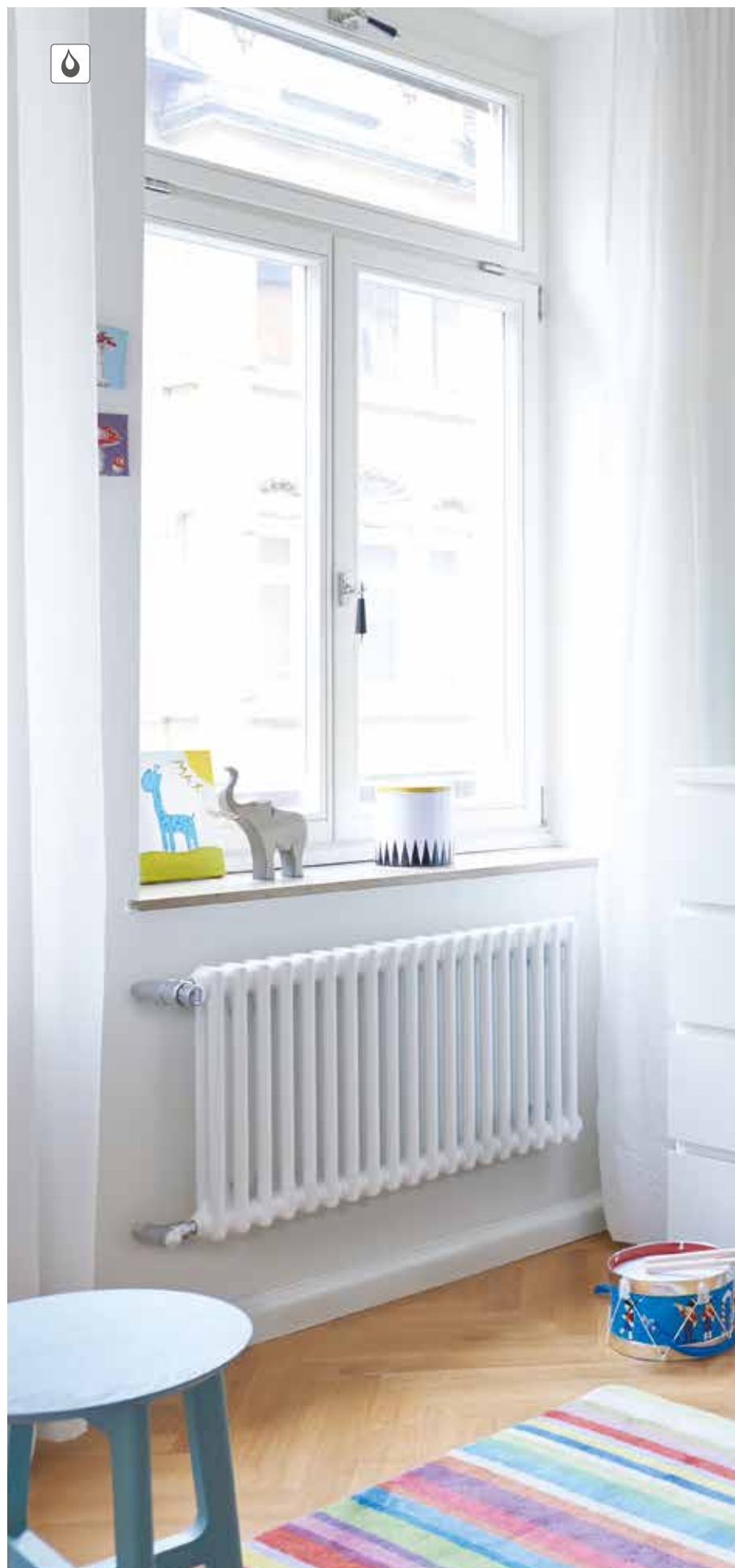
Heizkörper-Farbe: Traffic White
